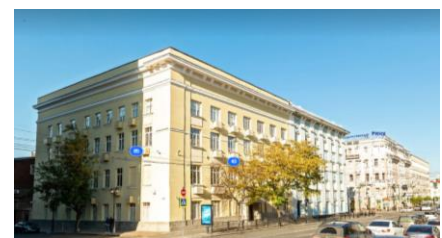
Ростов-на-Дону, пр. Ворошиловский, 43. Реконструкция здания Стройбанка
